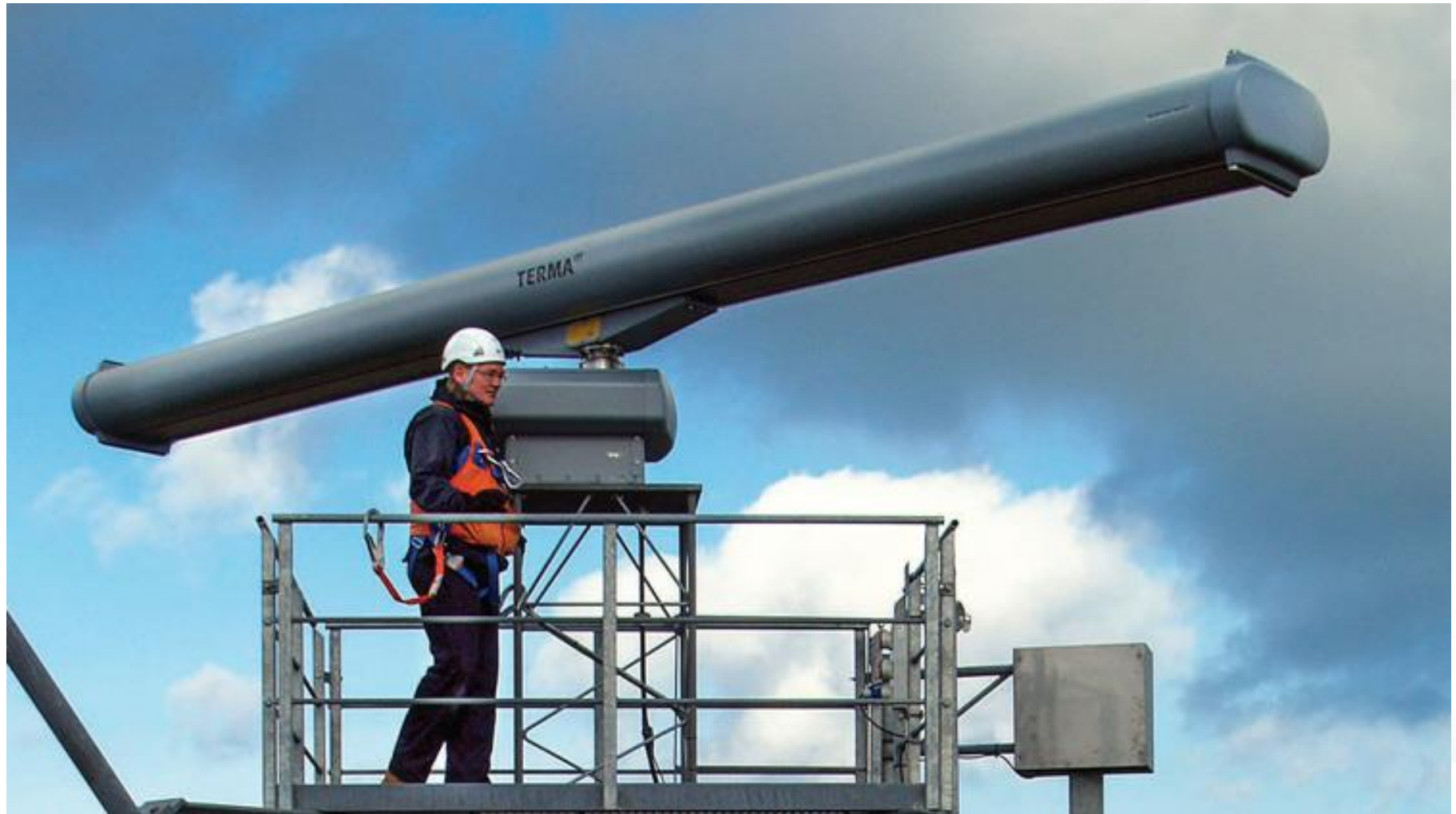
Terma Radar Anlage, Quelle: Terma.com
