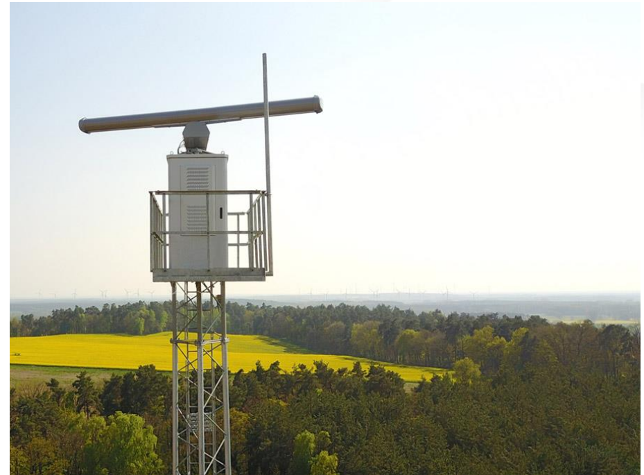
Radaranlage Terma, Quelle: Quantec
