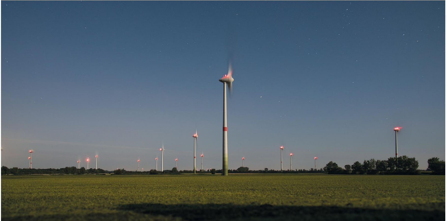
Bedarfsgerechte Nachtkennzeichnung im Windpark, Quelle: Lanthan, Pressemitteilung
