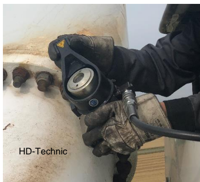
Flanschverbindung / Drehmomente
