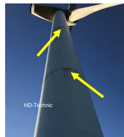
Korrosionsschäden
