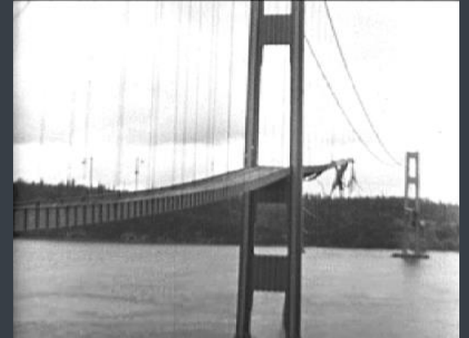
Einsturz der ersten Tacoma-Narrows-Brücke : 7. November 1940 Quelle: Wikipedia
