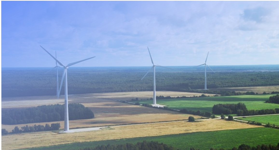
Bildquelle: Der Finnische Windenergieverband
