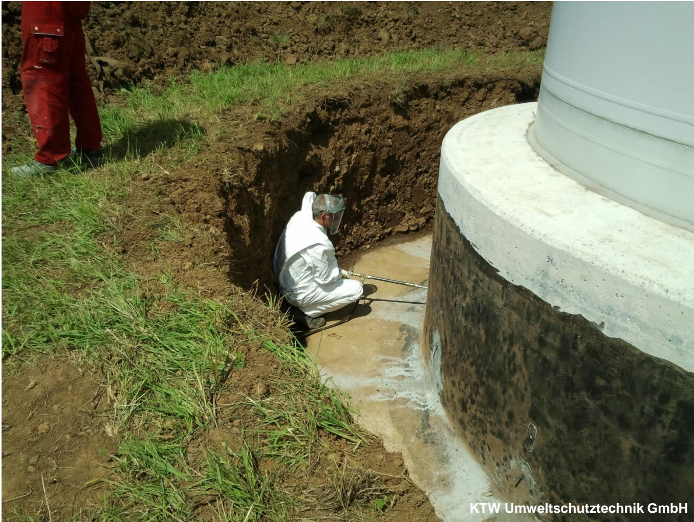
Verpressen von Sockelfundamenten
