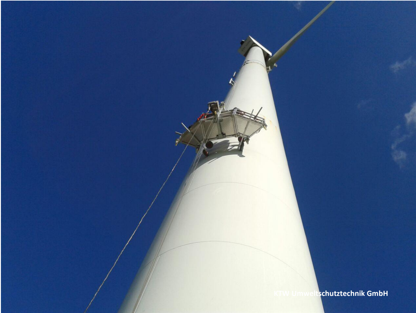
Sanierung von Tragwerken mit Aufzugstechnik
