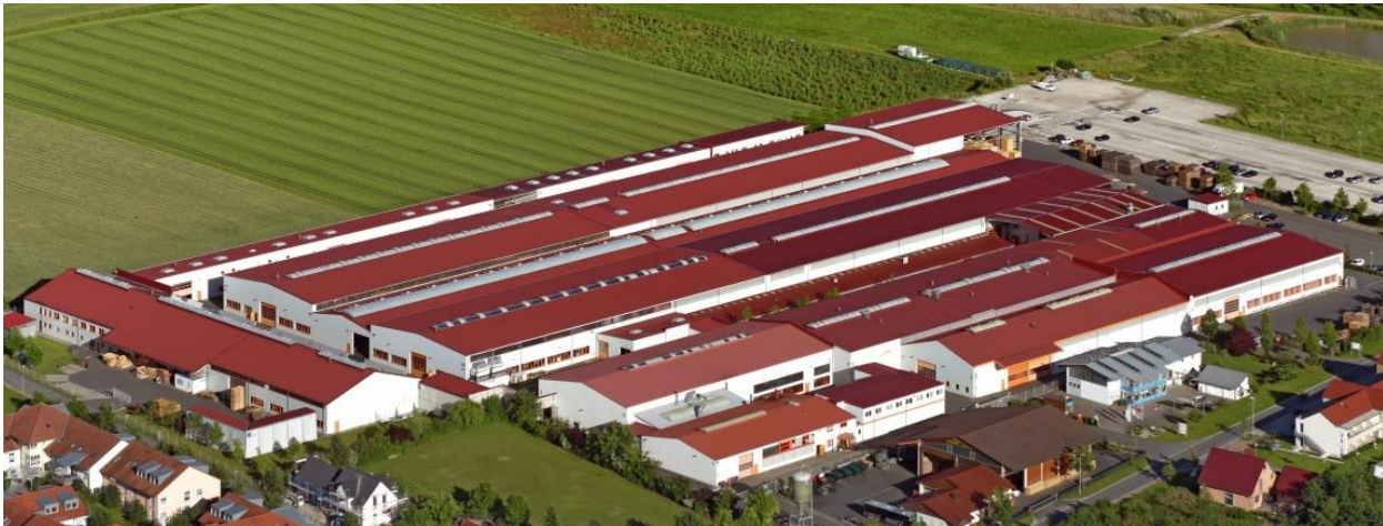
Werke in Gremsdorf bei Nürnberg
