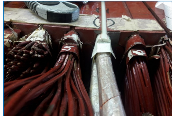
Bestückung mit vorgefertigten Strängen
