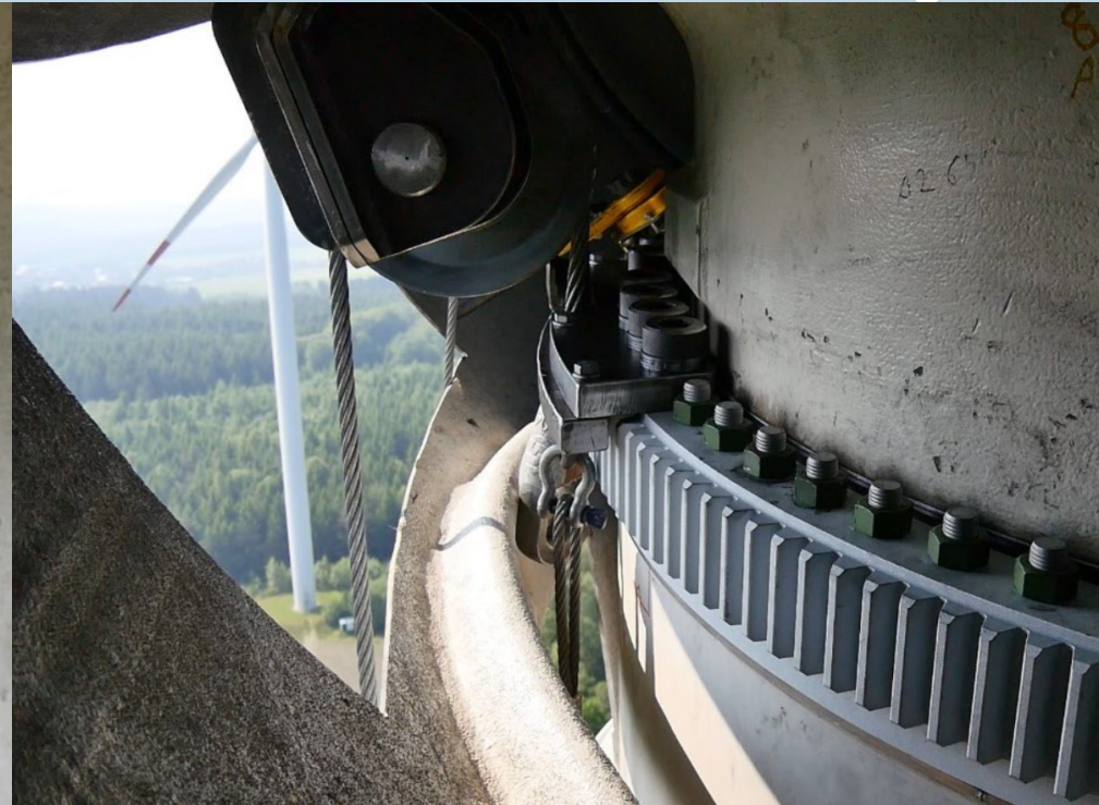
Absenken des Rotorblattes im Anstellwinkel zur Rotornabe
