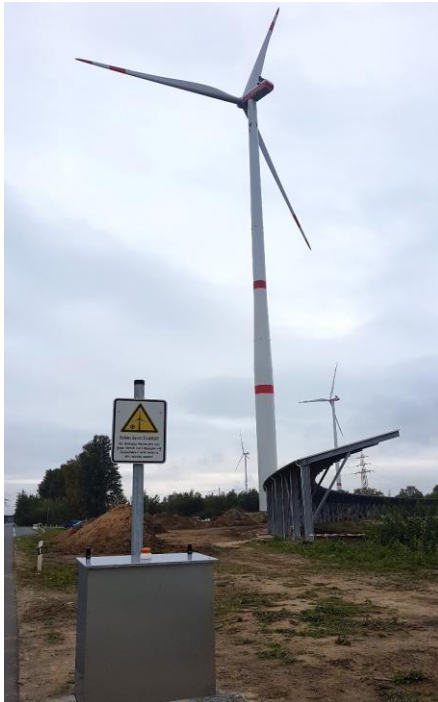
Warneinrichtung-geschlossen und Überdachung der Bahnschiene gegen Eisabfall (Quelle: Hunwardsen)
