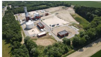
Leipheim bnBm H 2 -ready Gaskraftwerk
