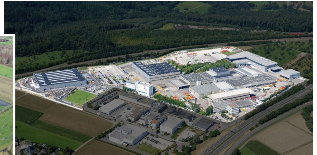
Putzmeister; Werk in Aichtal
