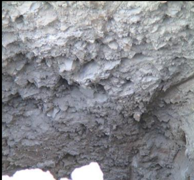
▪ Locker gelagerte Auffüllung
